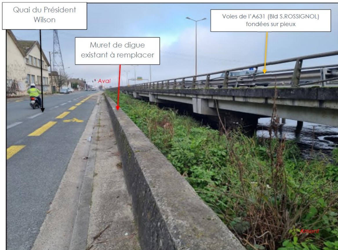
Photo du site prise de l'amont vers l'aval
